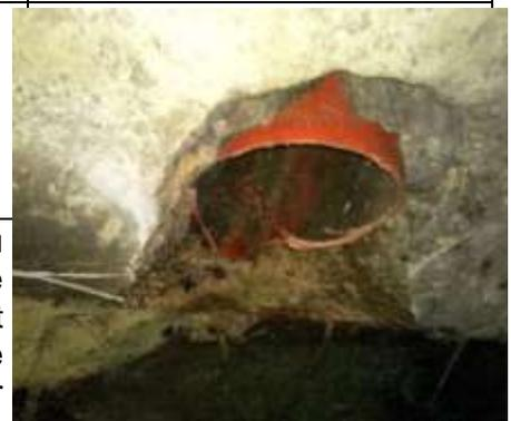
Rohr ausgefranst und zu kurz. Eine ordnungsgemäße Reprofilierung ist erforderlich, die bündige Herstellung mit der Kanalwand ist Bedingung
