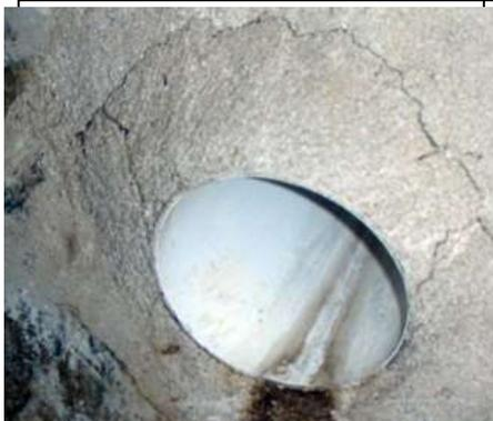
Rohr darf nicht überstehen, da hilft auch kein gewölbtes überschmieren mit untauglichem Mörtel
