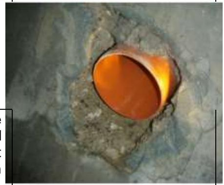
Brutal eingestemte Kanalöffnungen sind ordnungsgemäß mit kunststoffmodifizierten Beton instandzusetzen.
