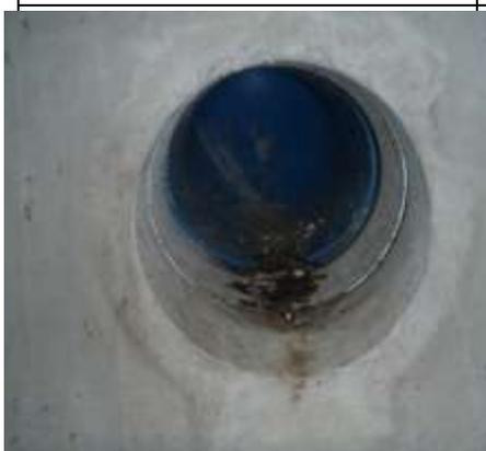
Rohr muss so lang sein, dass es bündig mit der Innenseite des öffentlichen Kanals abschließt – dieses Rohr ist zu kurz
