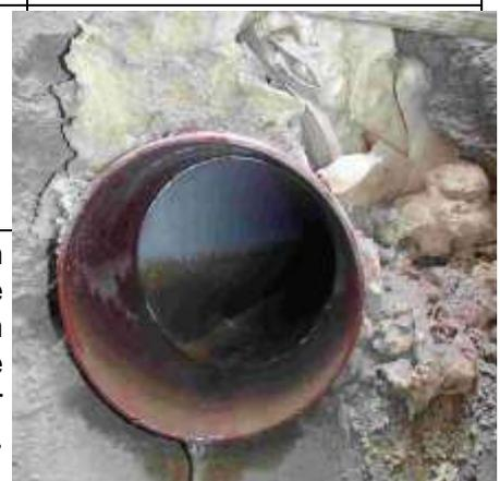
Kernbohrung von innen nach außen vermeidet solche garvierenden Schäden am Kanal und hohe Instandsetzungskosten für Verursacher.
