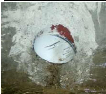
Rohr darf nicht überstehen – hier wurde versucht, das mit Mörtel zu verschmieren
