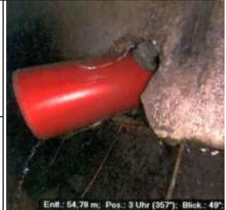
Rohr darf nicht zu knapp über Sohle (Klinkersohle) eingemündet werden, es darf nicht überstehen, die Kanalwand darf nicht beschädigt werden.
