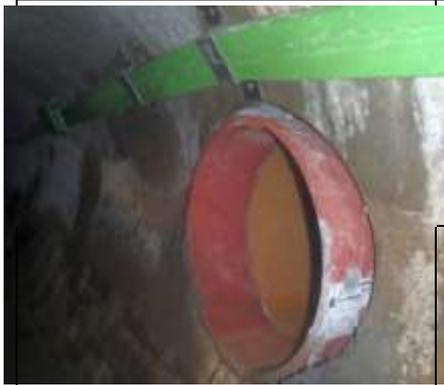
Rohr darf nicht überstehen sondern muss bündig nach der Wölbung des Kanals abgetrennt werden.
